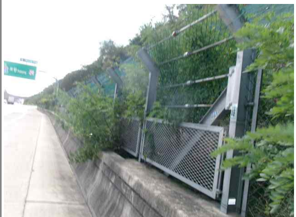
도로, 낙석방지울타리 전경
