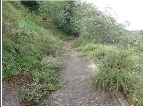
1소단 배수로 전경
