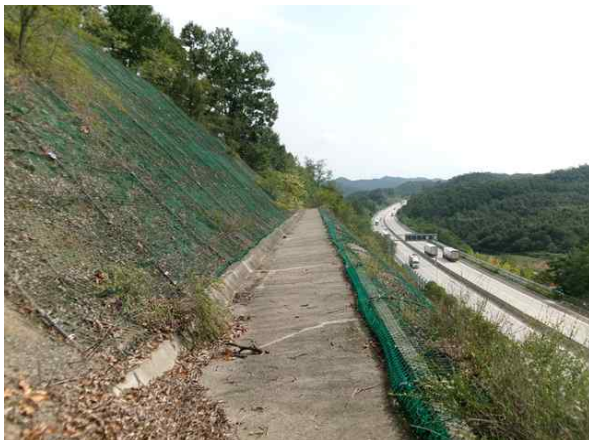
1소단 배수로 전경
