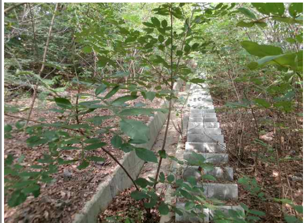
산마루측구, 점검계단 전경
