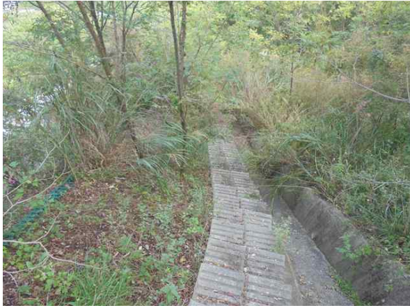
산마루측구, 점검계단 전경
