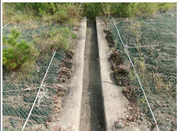
숏크리트, 점검계단 전경
