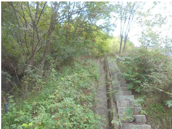
산마루측구, 점검계단 전경
