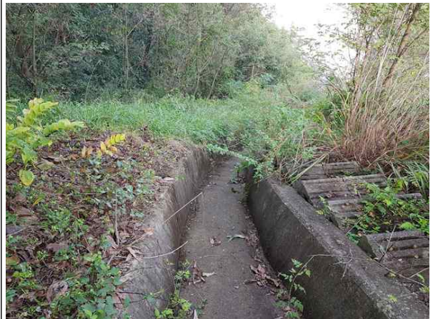
점검계단, 산마루측구 전경
