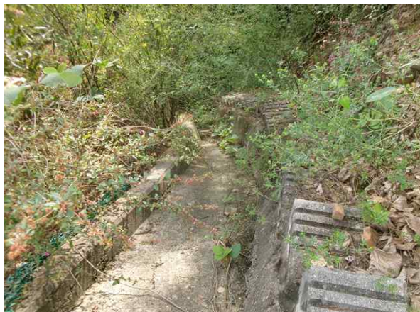
산마루측구, 점검계단 전경
