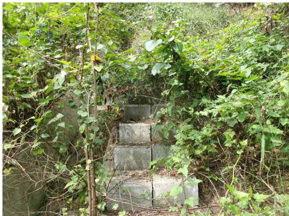
산마루측구, 점점계단 전경
