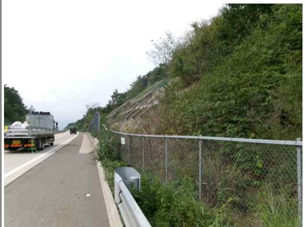
도로부, 야생동물유도울타리 전경
