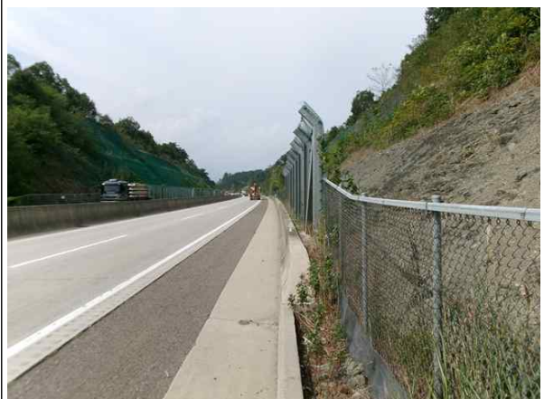
도로부 및 낙석방지울타리 전경
