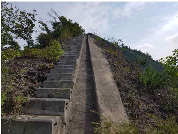
산마루측구, 점검계단 전경
