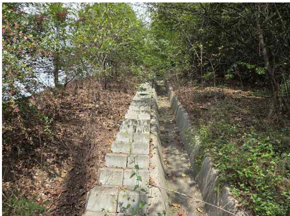
산마루측구, 점검계단 전경
