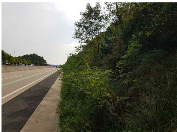
도로, 낙석방지울타리 전경
