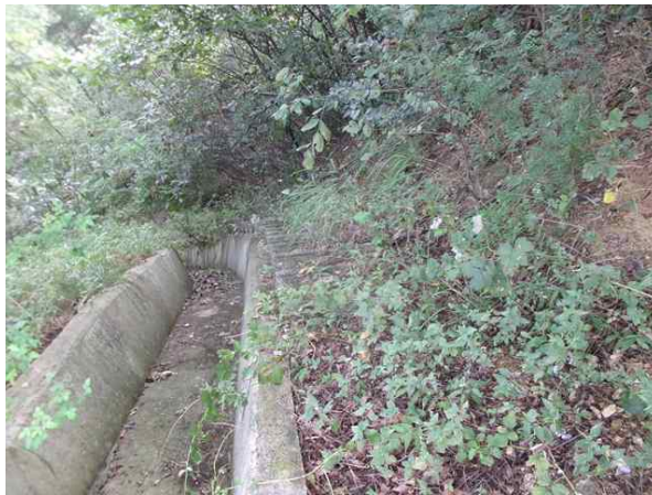
점검계단 및 산마루측구 전경
