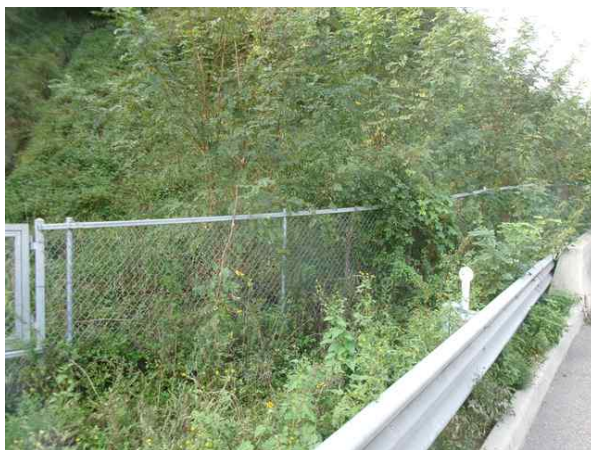
도로부, 야생동물방지울타리 전경
