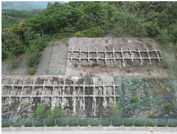
-shotcrete, 격자블럭 전경
