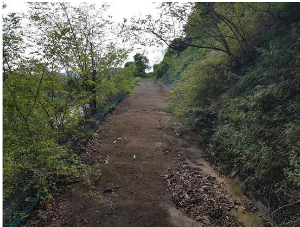
1소단 배수로 전경
